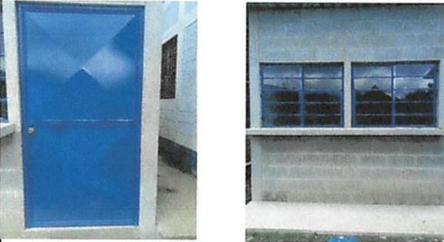
foto 3. las puertas y ventanas fueron sustituidas por nuevas
